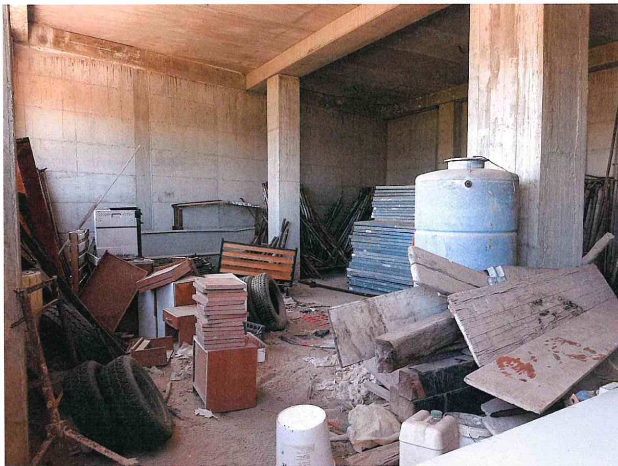
N° 15 INTERNO –PIANO SOTTOSTRADA-
