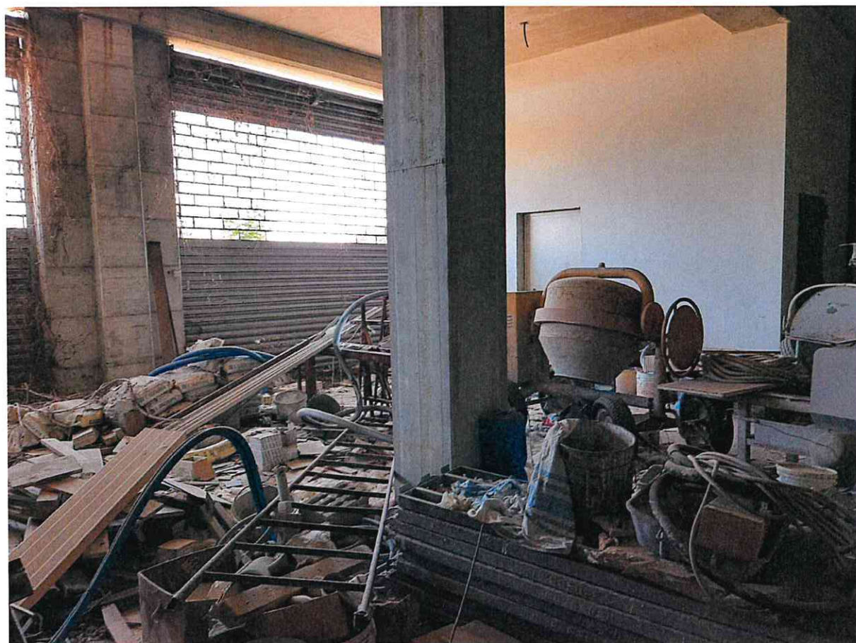
N° 16 INTERNO –PIANO SOTTOSTRADA-
